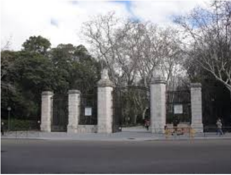
Entrada principal (valla)
